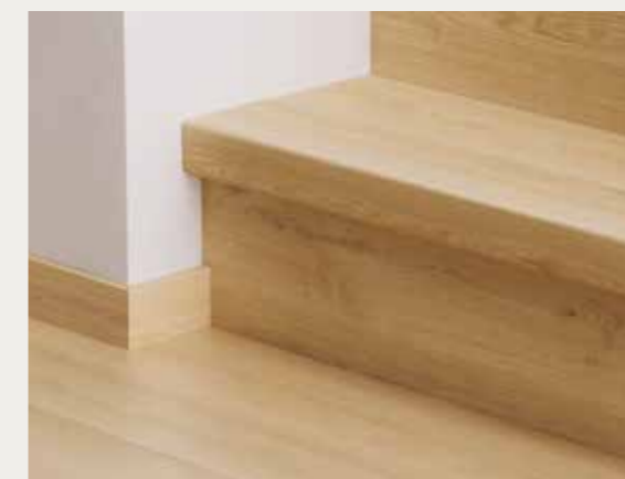
SCALA TOTALMENTE RICOPERTA Per un aspetto uniforme e continuativo.
