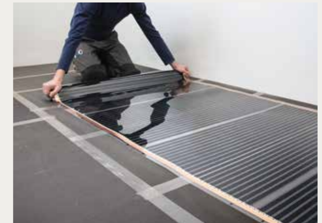
2 Installare il sistema multistrato QuickHeat.
