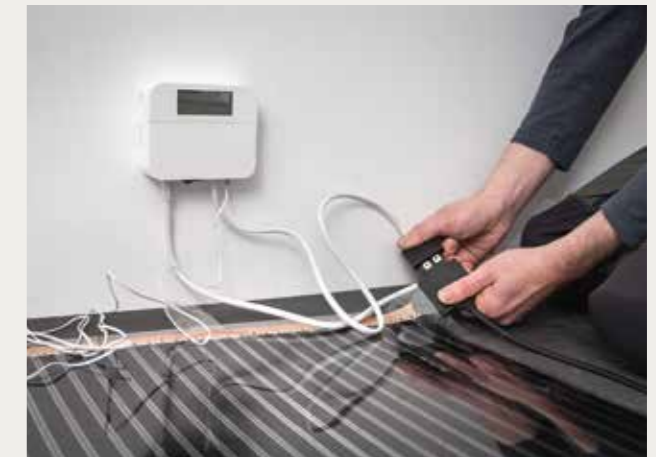
4 Montare l'unità di comando e collegarla al foglio riscaldante.
