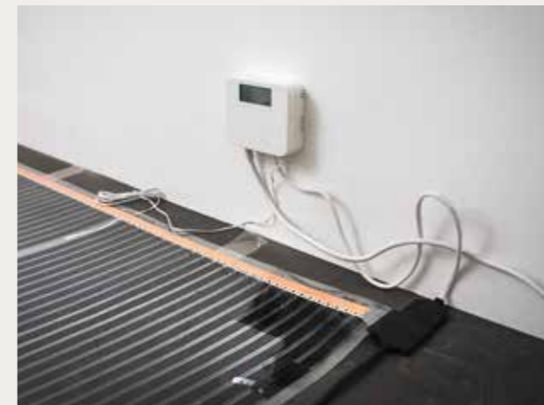
5 Inserire la spina dell'unità di comando nella presa a muro.
